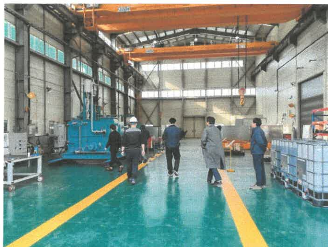
天井クレーン 20Ton, 10Ton
